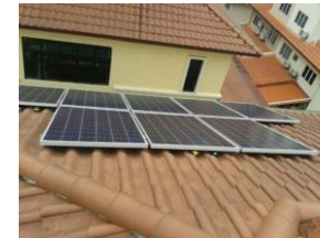
Cheras Hartamas KL, 4kWp
